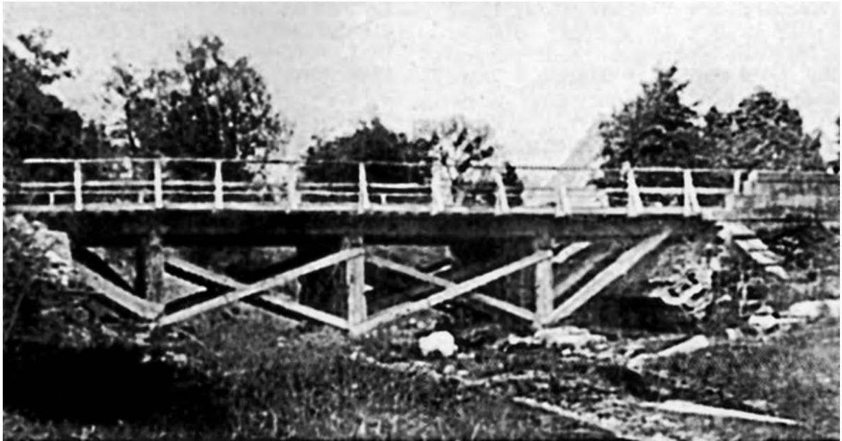
*Ganz séier hat eng amerikanesch Genie-Trupp eng Noutbréck aus Holz iwwert d'Äisch gebaut. Dës stabil Konstruktioun ass eréischt ugangs 1950 duerch eng Bréck aus Beton-armé ersat ginn.*
